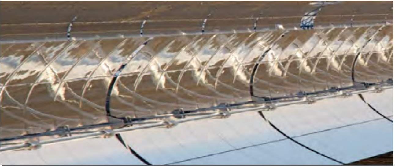
Colectores cilindro parabólicos
