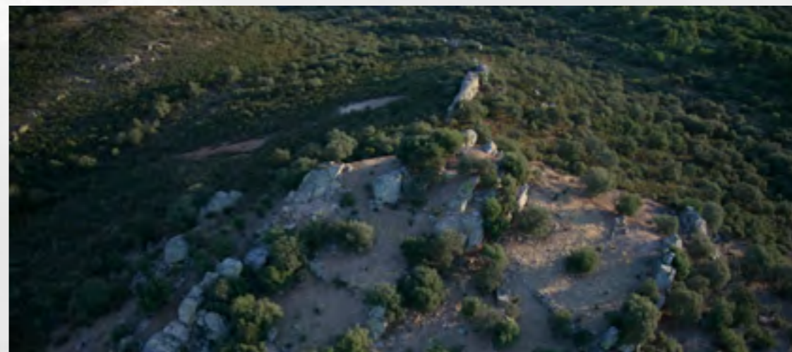
Figura 2: vista aérea del Castejón de las Merchanas (Don Benito), una de las fortificaciones de La Serena objeto de estudio.
